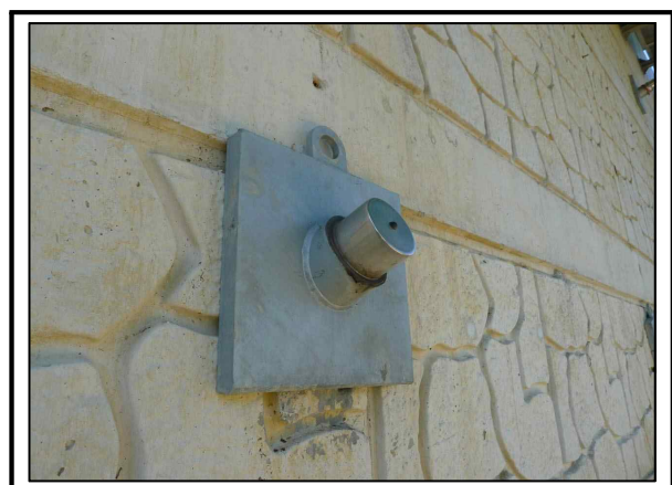
사진번호 42 교대 A1 어스앵커 외관망도 - 보강현황
