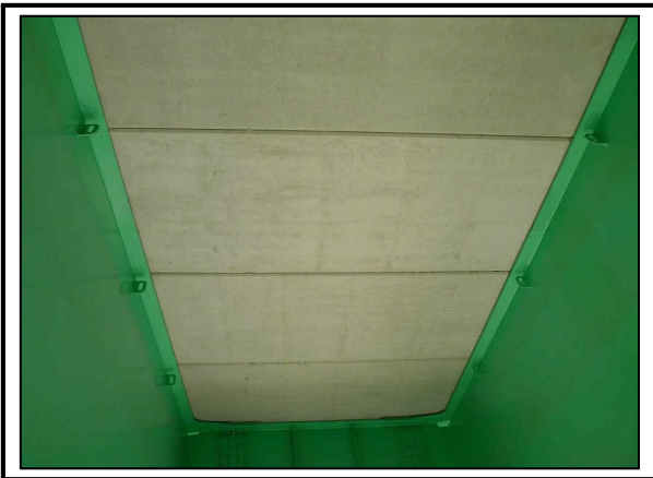
사진번호 25 바닥판 S1 상태양호 외관망도 -
