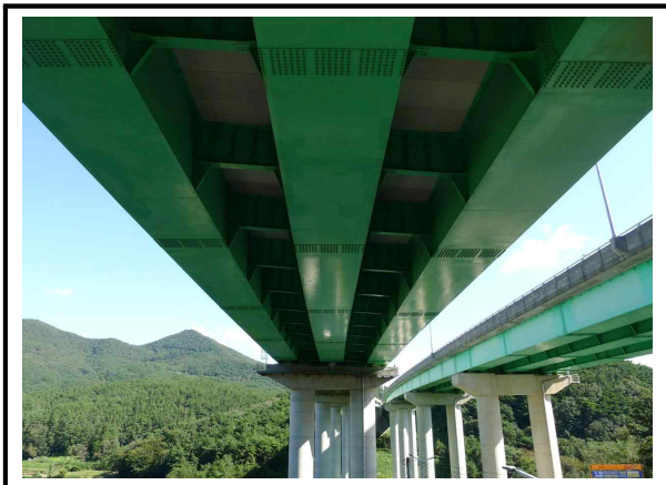
사진번호 9 거더 및 바닥판 전경 외관망도 -
