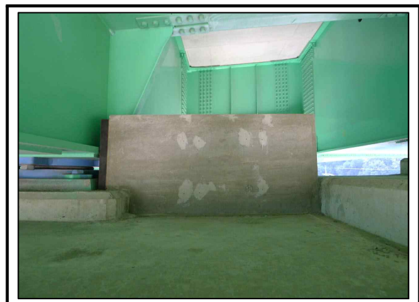
사진번호 40 교량받침 P1 콘크리트 외관망도 - 전단기 설치현황
