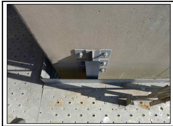
사진번호 56 교각 P3 점검통로 브라켓 및 앵커볼트 상태양호 외관망도 -
