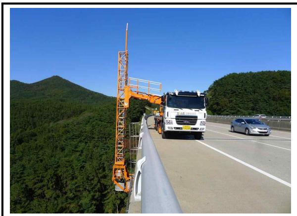
사진번호 59 교량점검차량을 이용한 외관조사현황 외관망도 -
