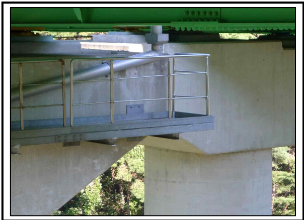
사진번호 53 교각 P4 점검통로 보수현황 외관망도 -
