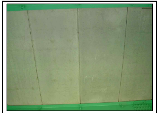
사진번호 26 바닥판 S6 상태양호 외관망도 -
