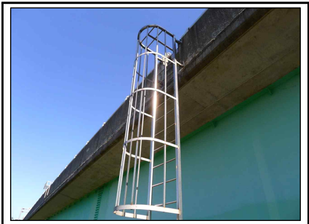
사진번호 51 교각 P5 출입시설(수직형) 외관망도 -
